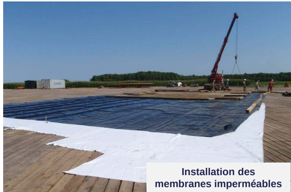
Aménagement du site du puits A261(2008)
